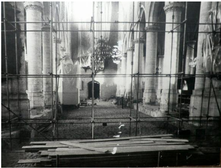
Dit is een overzicht van foto's die zijn gemaakt tijdens de restauratie in 2000-2010.
