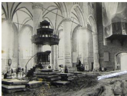
De Pieterskerk tijdens de restauratie.
