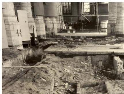
De Pieterskerk tijdens de restauratie.
